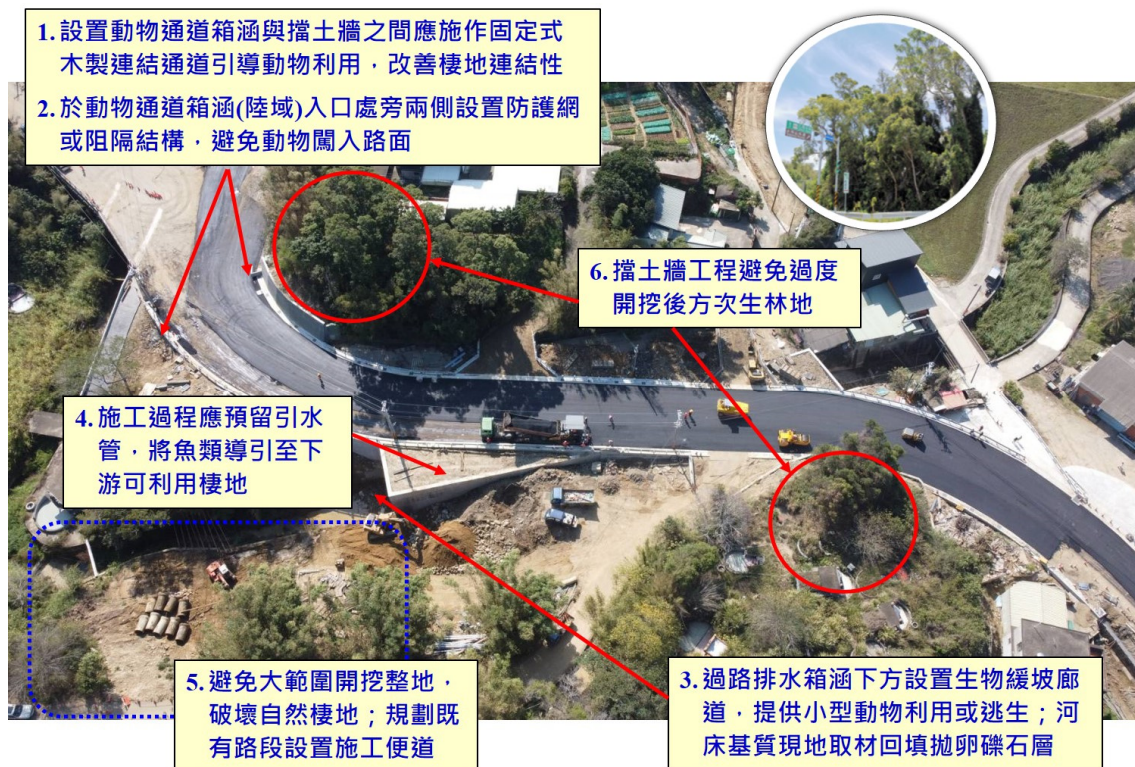
三灣鄉苗 17 線瓶頸路段拓寬改善工程生態檢核成果示意圖
